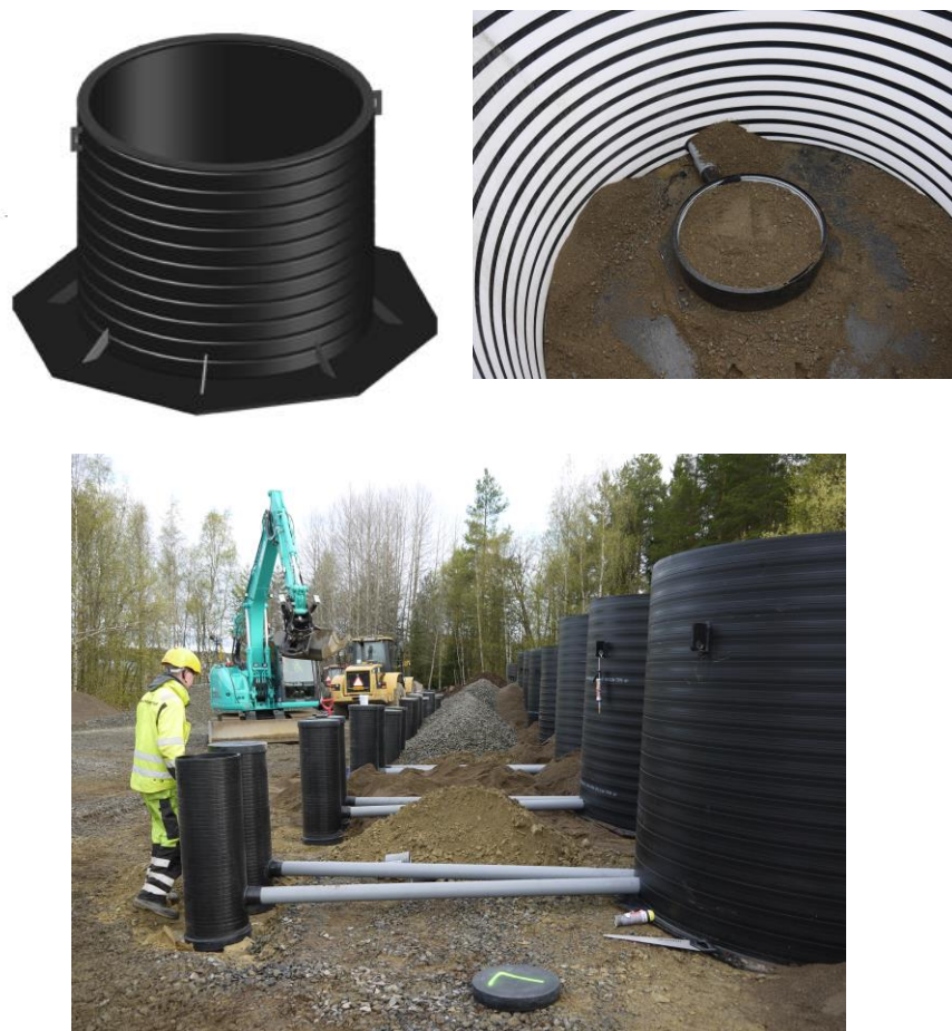
Figure 1. Lysimeters in Pyhäsalmi Mine. (Karjalainen, N., Autiola, M. and Jyrävä, H. 2016.)
